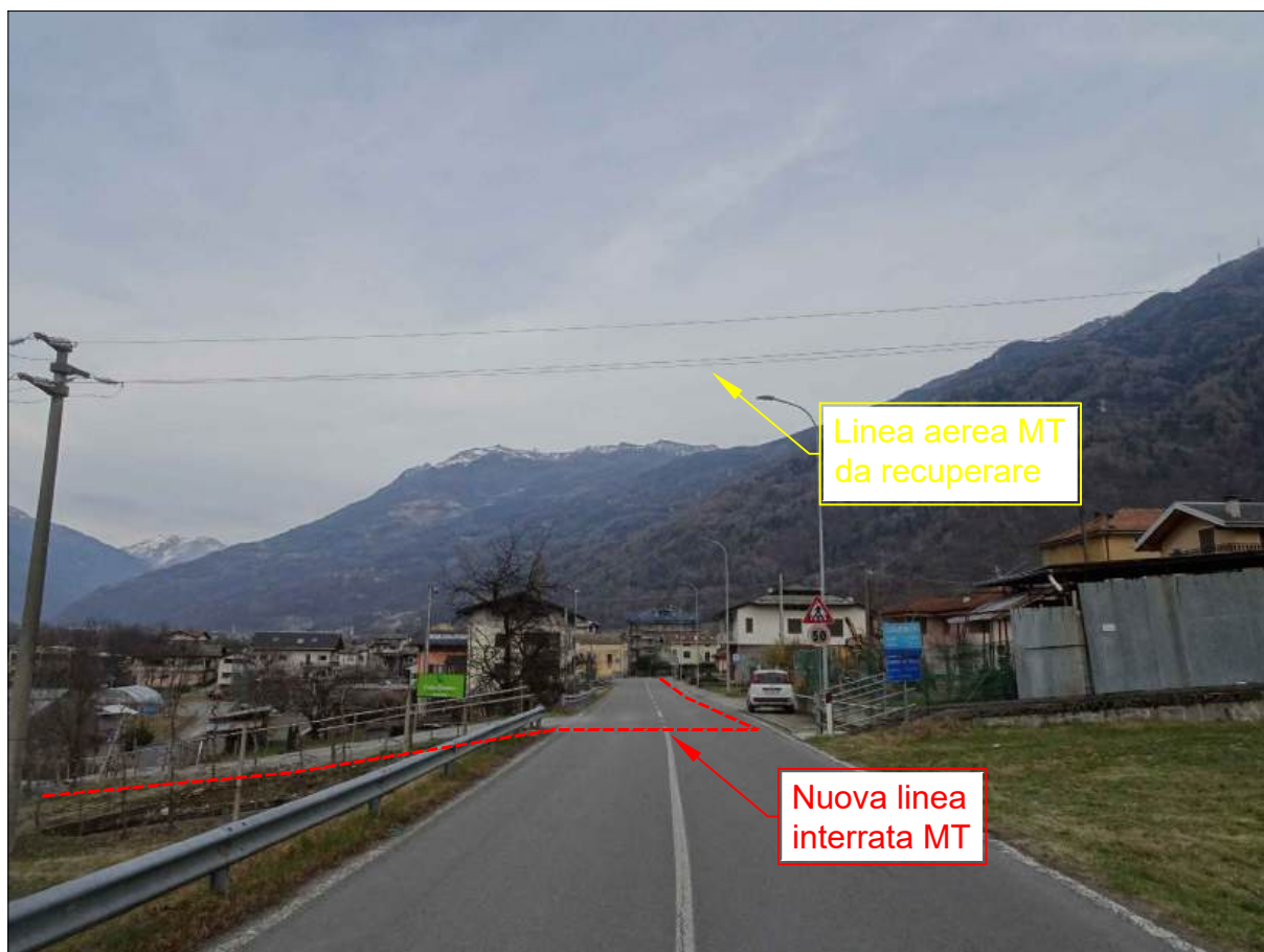
FOTO 1: VIA ROMA (S.P. n°27) POSA NUOVA LINEA INTERRATA MT
