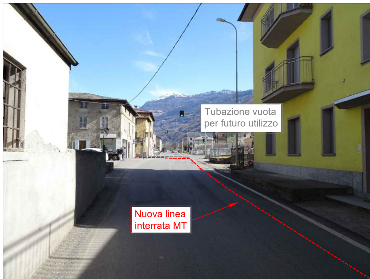
FOTO 5: VIA ROMA (S.P. n°27) POSA NUOVA LINEA INTERRATA MT
