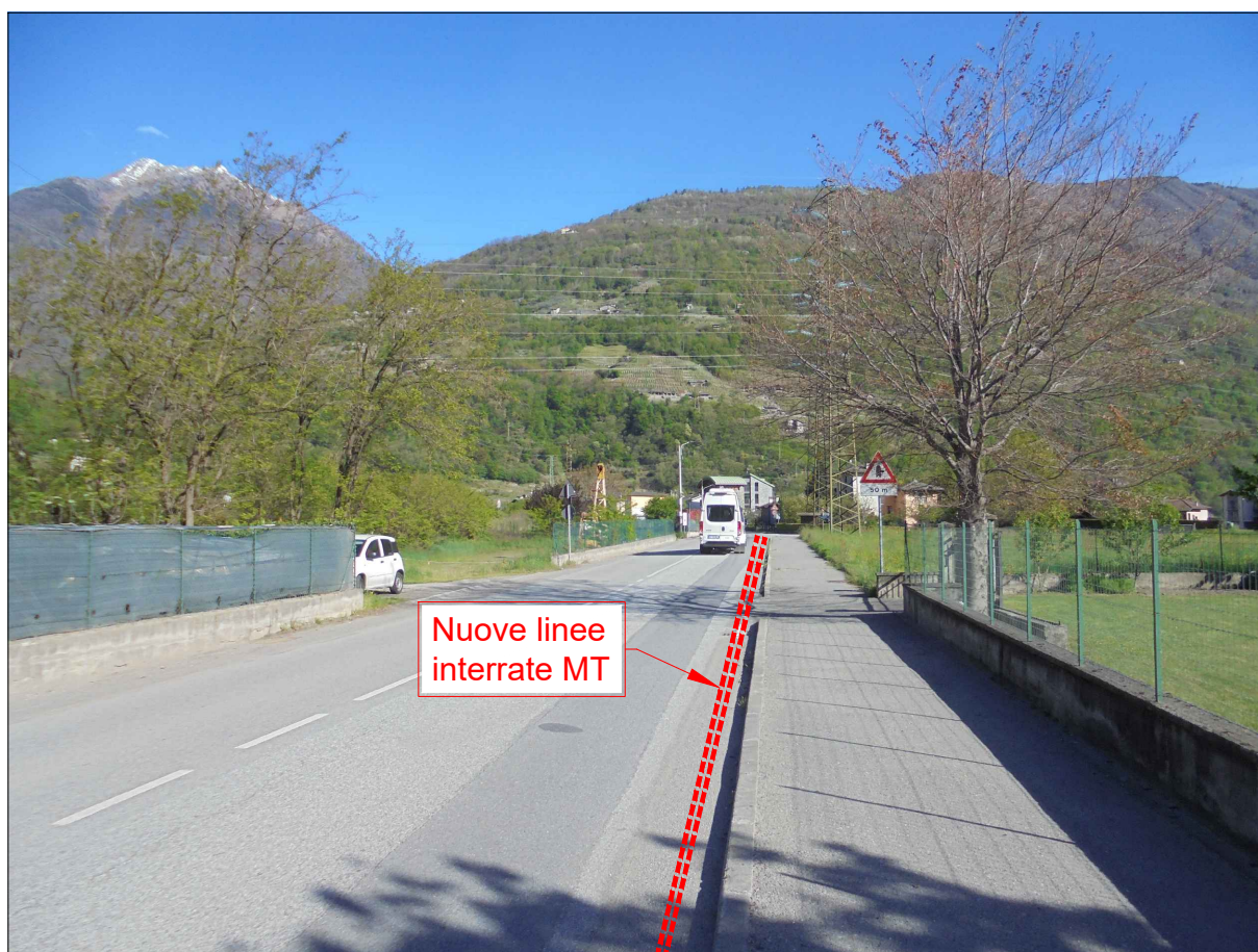
VIA DEI MOLINI (S.P. n°9) POSA LINEA INTERRATA MT
