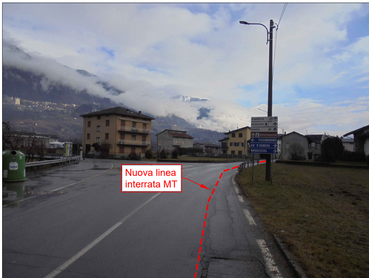
VIA PRADELLA (S.P. n°19) POSA NUOVA LINEA INTERRATA MT
