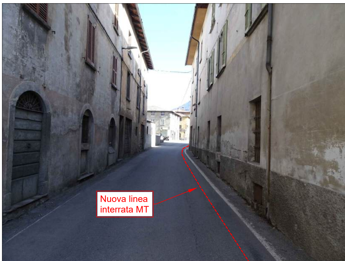
FOTO 4: VIA ROMA (S.P. n°27) POSA NUOVA LINEA INTERRATA MT
