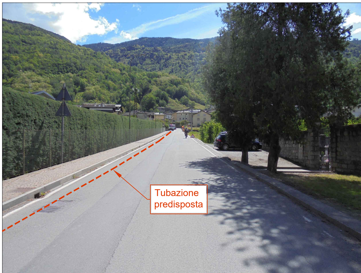
FOTO 2: VIA COLOMBERA (S.P. n°25) POSA NUOVO CAVO IN TUBAZIONE PREDISPOSTA
