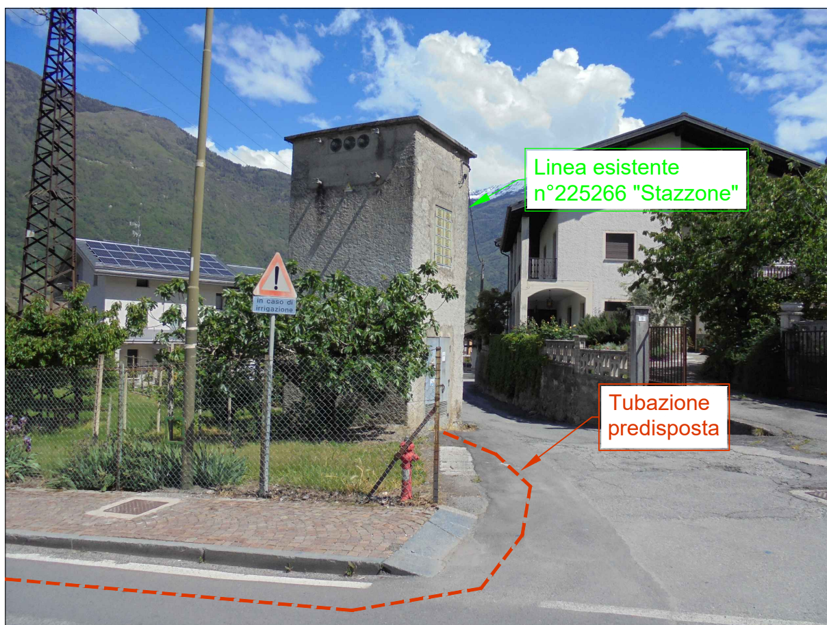
FOTO 4: VIA COLOMBERA (S.P. n°25) POSA NUOVO CAVO IN TUBAZIONE PREDISPOSTA
