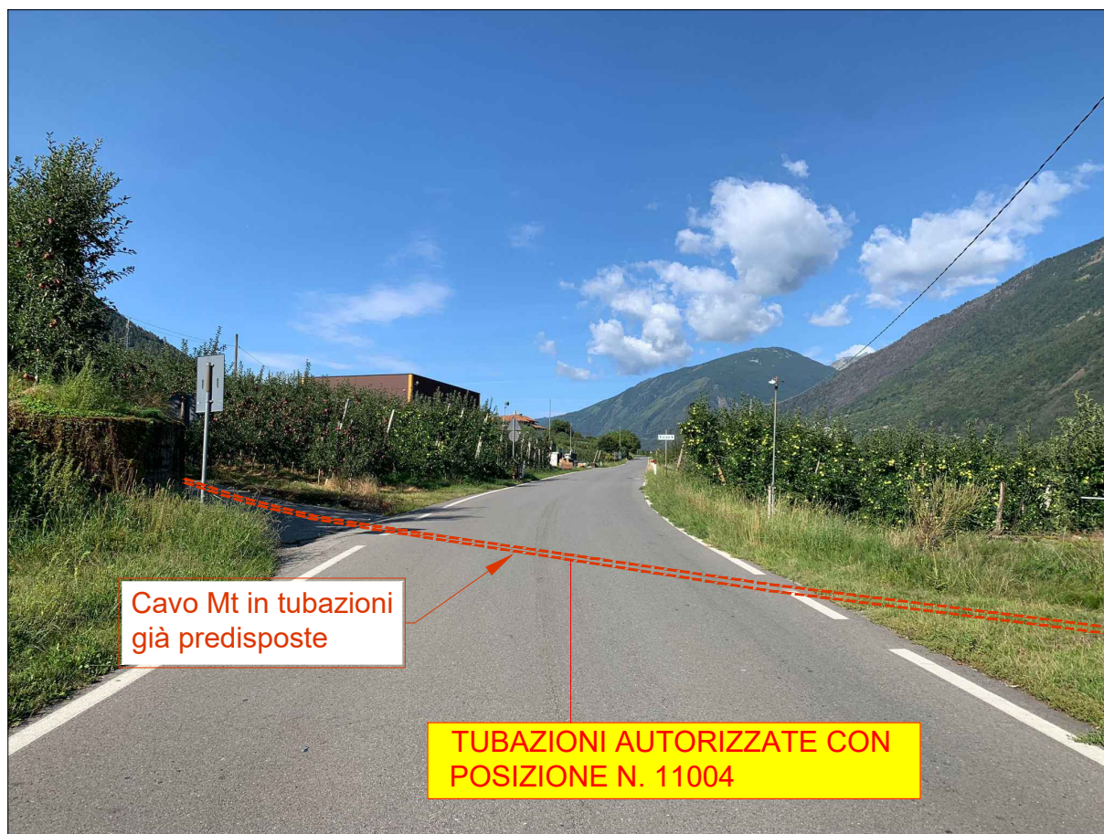
FOTO 1: VIA ROMA (S.P. n°26) POSA NUOVA LINEA INTERRATA MT IN TUBAZIONI GIA' PREDISPOSTE
